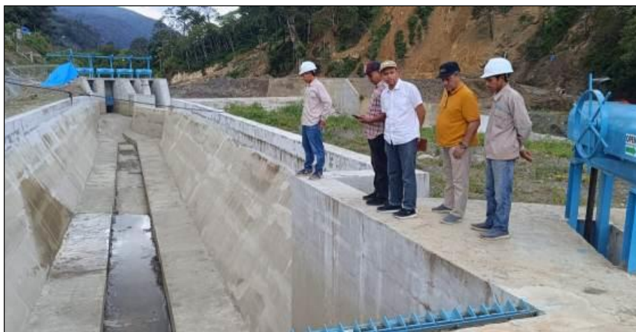
Tim Dinas ESDM Aceh saat meninjau lokasi bendungan beserta komponen sipil pendukung (intake, head race dan forebay) pada PLTM Pantan Cuaca.
