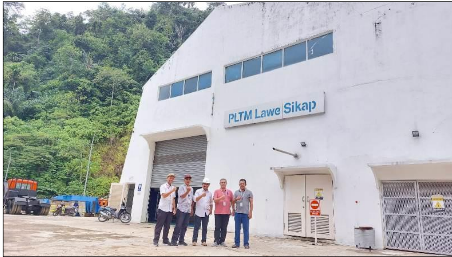
Tim Dinas ESDM Aceh saat mengunjungi Kantor Lapangan (Site Office) PLTM Lawe Sikap didampingi Site Engineer ketika meninjau pengoperasian pembangkit.
